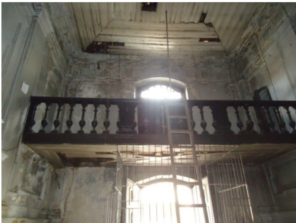
Figura 8 – Vista interna da Capela Pombo
