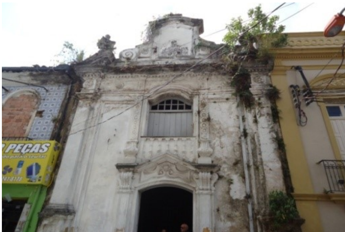
Figura 1 – Fachada da Capela Pombo
