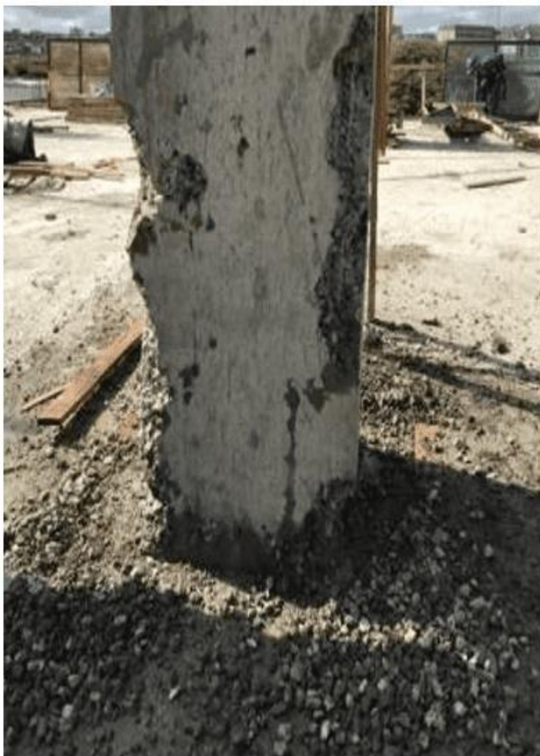
Figura 7- Pilar com desagregação de concreto
