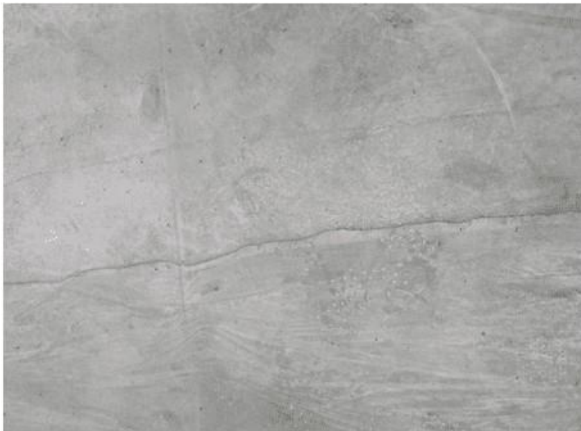
Figura 5 - Fissuras longitudinais nas lajes do subsolo 1
