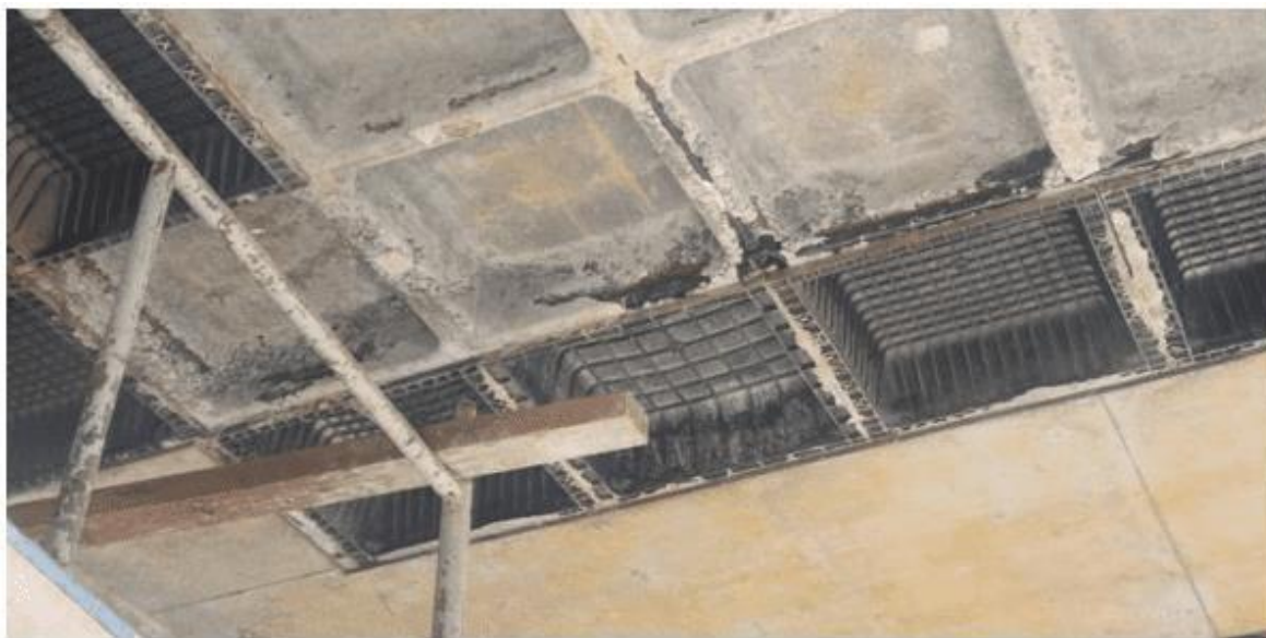
Figura 3 - Segregação em nervuras da laje
