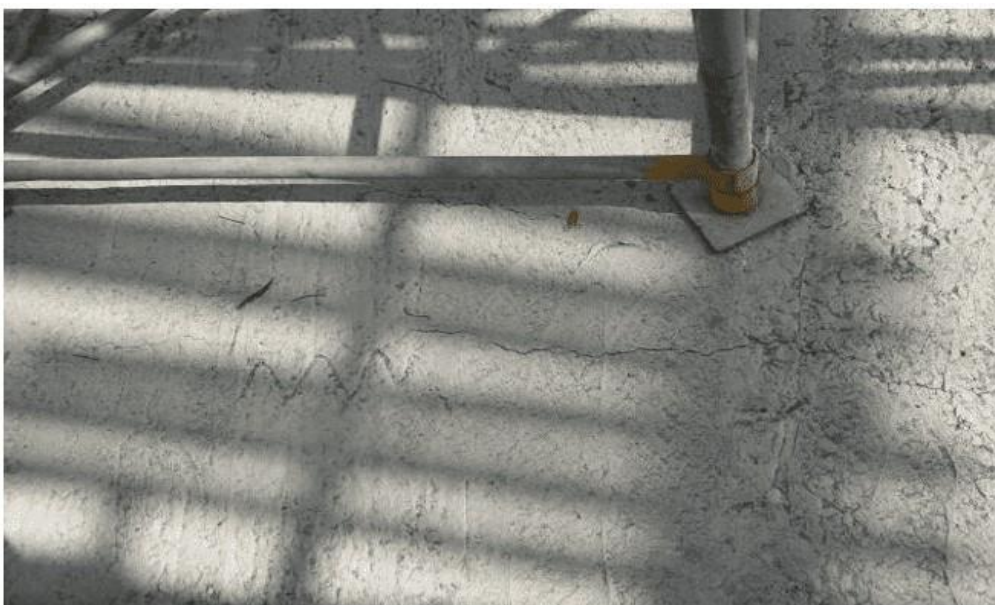
Figura 6 - Fissuras longitudinais no térreo
