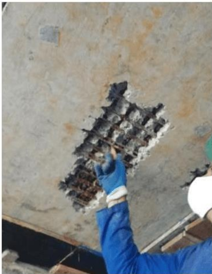
Figura 4 - Segregação em viga da laje
