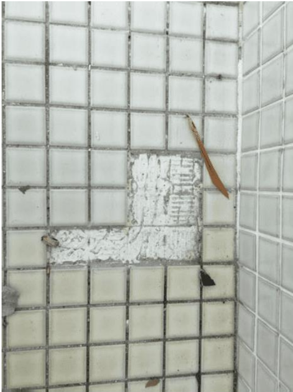
Figura 05 – Mureta do Edifício.
