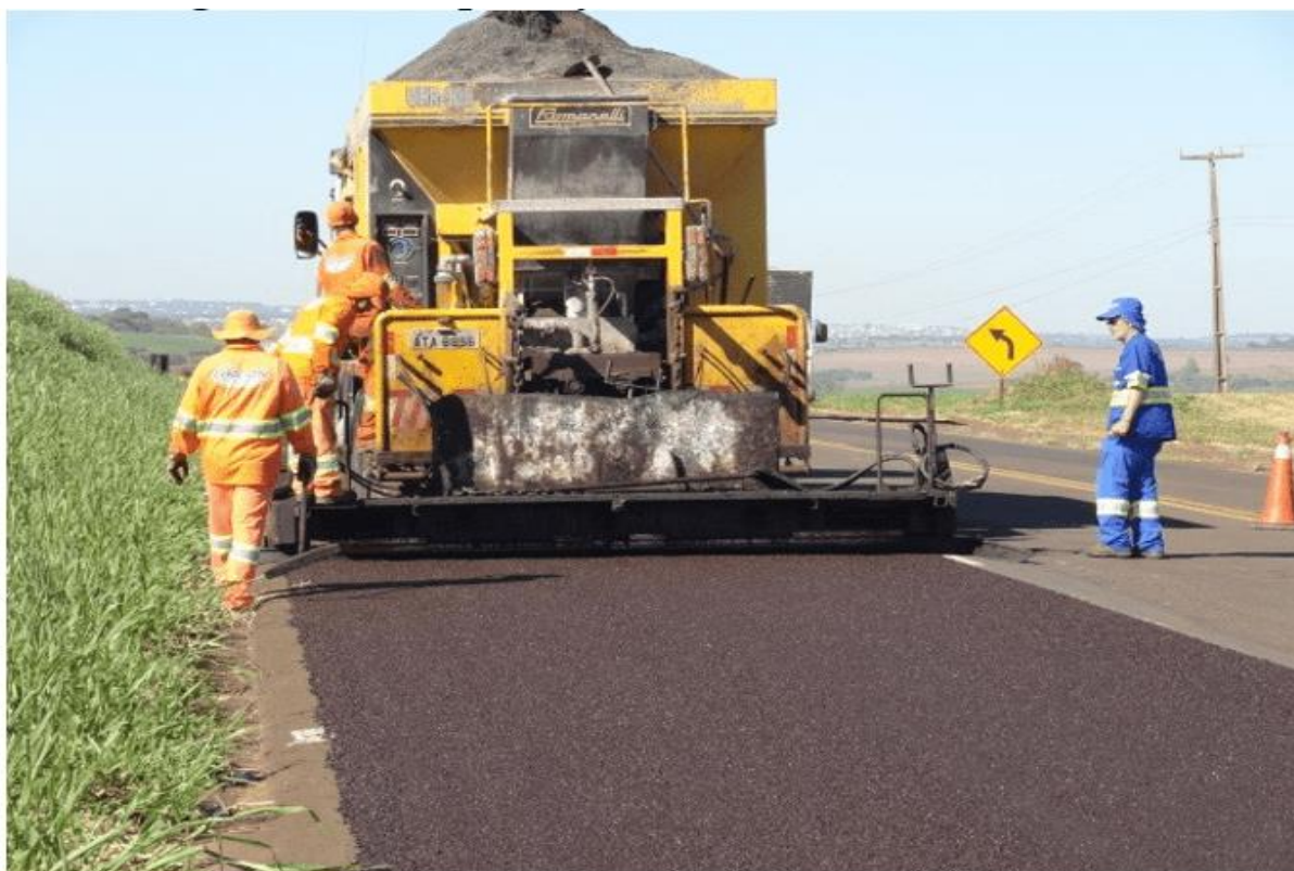
Figura 10 – Aplicação de micro revestimento
