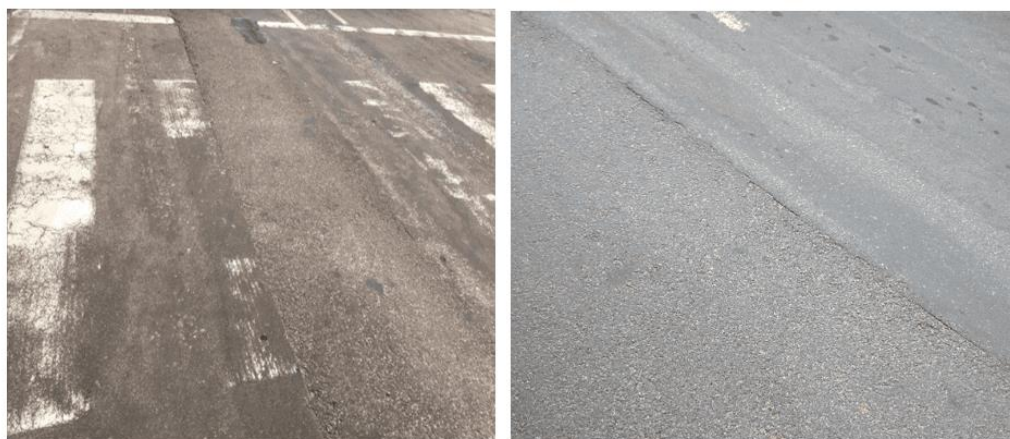
(a) – Sobre o remendo da rede de abastecimento (b) – Afundamento por influência plástica
