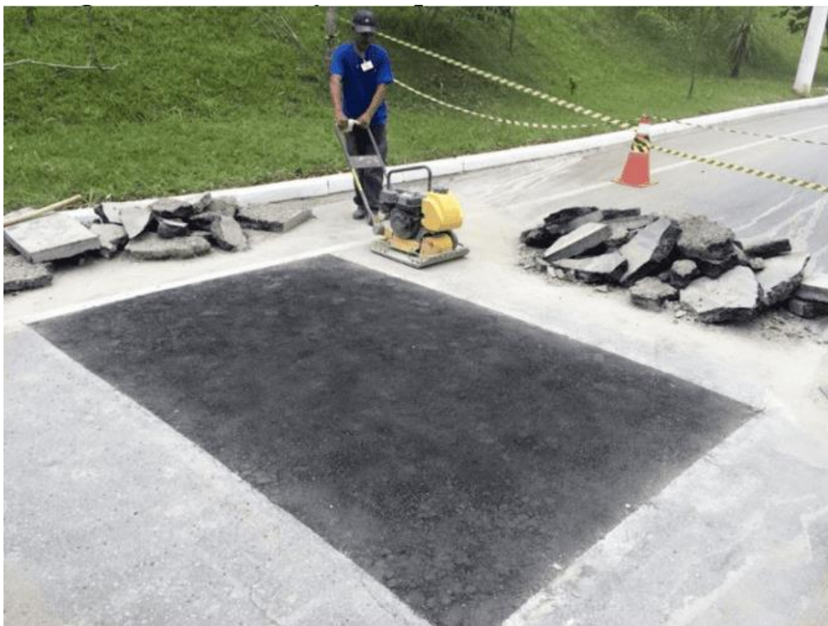
Figura 12 – Correção do pavimento com remendos
