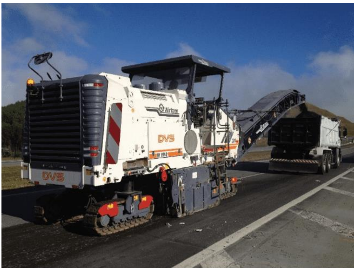
Figura 11 – Processo de fresagem
