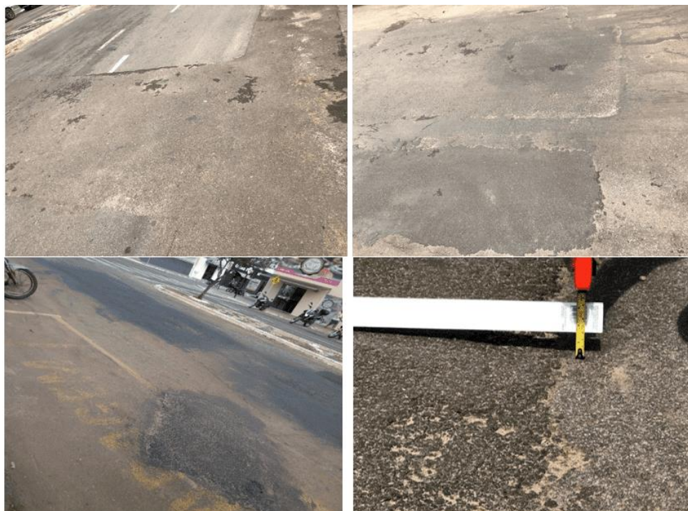
(a) – Remendos das redes (b) – Remendos sobre a via
