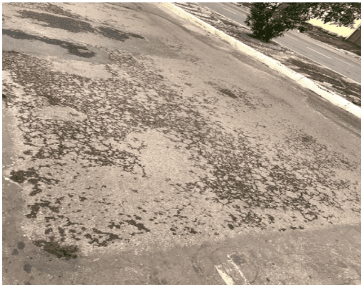
Figura 3 – Fendas sobre remendos na avenida
