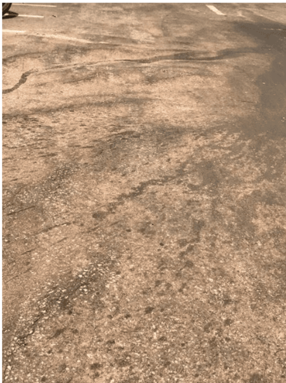
Figura 5 – Ondulações sobre a via
