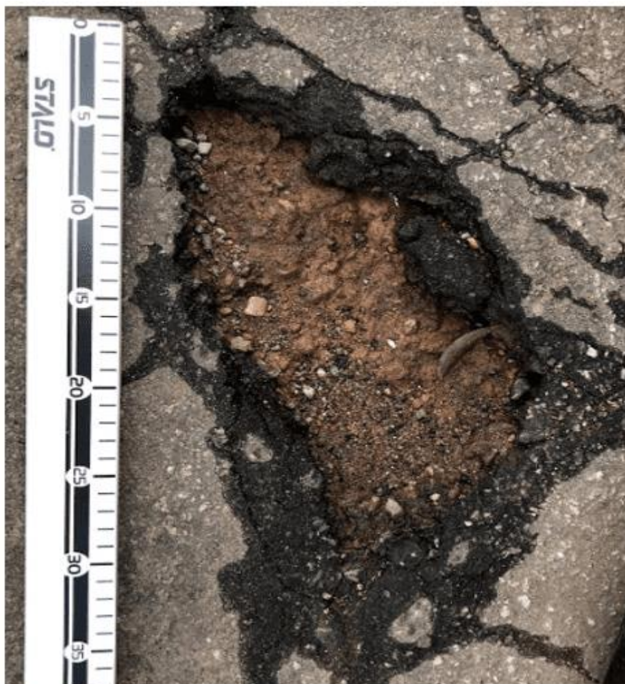
Figura 8 – Buracos no pavimento
