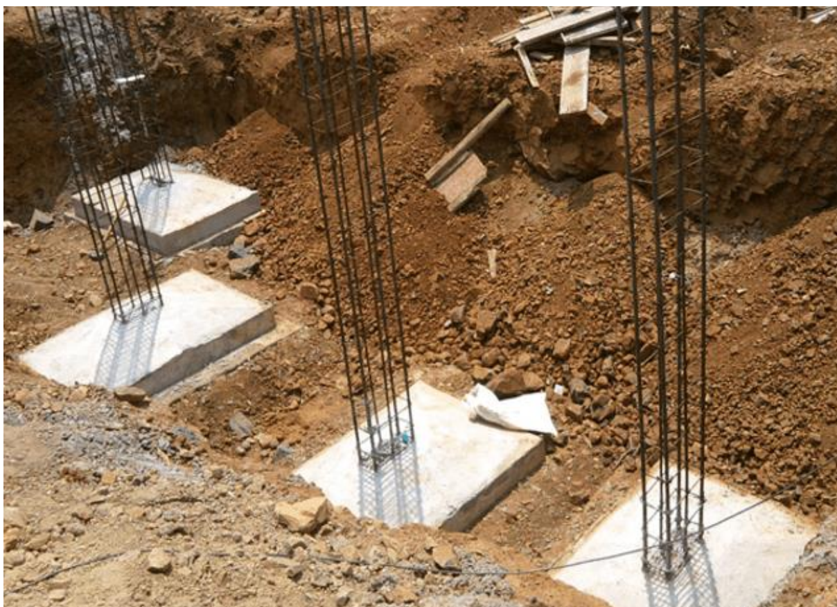
Figura 25: Sapata Isolada.
